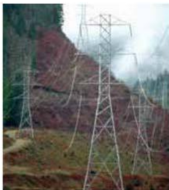
Опори ліній електропередачі
